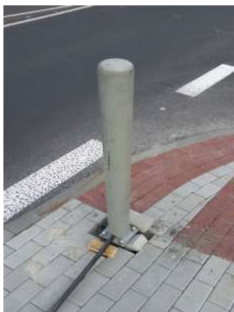
obr. způsob montáže ocelového zábradlí
