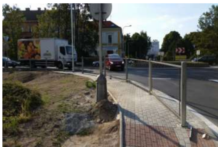
obr. způsob montáže ocelového zábradlí
